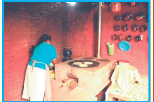
Imagen 4: Estufa patsari instalada en una cocina tradicional del estado de Michoacán. Fotografía: GIRA A. C. s. f.
