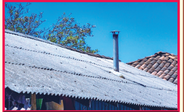
Imagen 3: Una característica de las EEL es que cuentan con una chimenea que expulsa hasta el 95 % del humo de la cocina. Fotografía: Jimena Paz Navarro, 2024.
