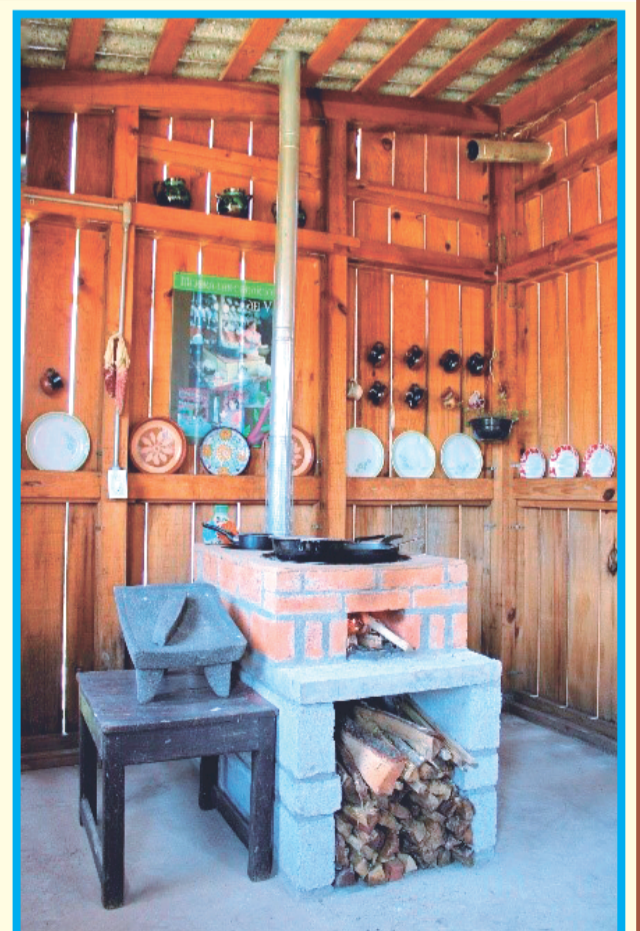
Imagen 2: Estufa patsari , modelo fijo con un comal principal y dos comales secundarios. Fotografía: Sandra Serrato Meza, 2025.
